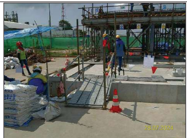
ฉ) กิจกรรมการติดตั้งหน่วยบำบัดน้ำทิ้งด้วยโอโซน (Advanced Oxidation Process; AOPs) เพิ่มขึ้น 1 หน่วย
