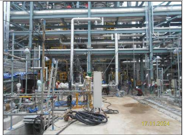
ง) กิจกรรมการติดตั้งระบบประเหียนน้ำทิ้ง (Zero Liquid Discharge; ZLD)
