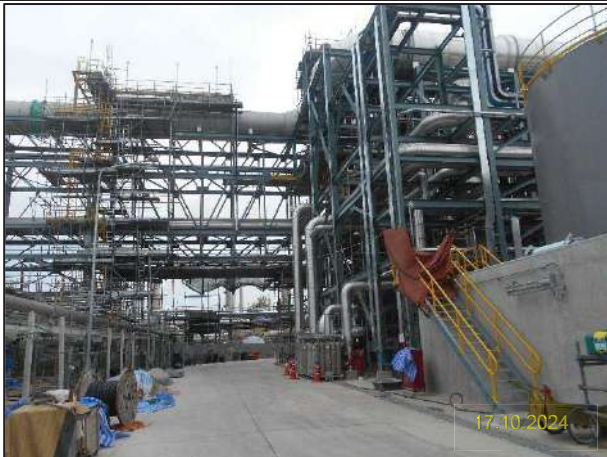
ค) กิจกรรมการติดตั้งหน่วยกำจัดกลิ่นแบบอาร์ทีโอ (Regenerative Thermal Oxidizer; RTO) และ SO 2 Scrubber
